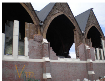
Figura 4. Një tërmet ka shkatërruar shumicën e mbulesës me tulla dhe xhamin e kësaj ndërtese.
