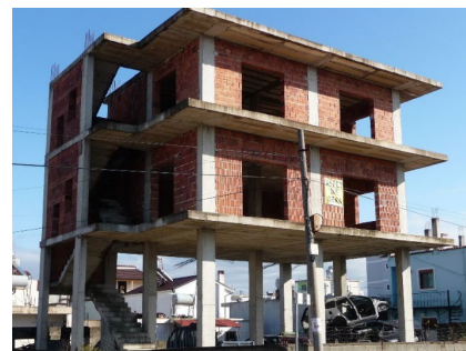
Figura 5. Një ndërtesë tipike me kate të buta ku kati i poshtëm është më i dobëti.
