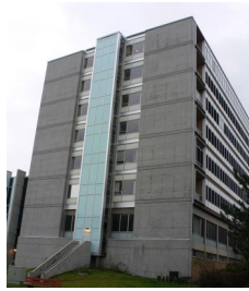
Figura 2. Rikonstrukcioni sismik i kësaj godine spitalore përfshinte dy mure të reja strukturorë dhe themele në çdo skaj.
