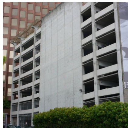
forcave që veprojnë përgjatë gjatësisë së ndërtesës. Duhet të ketë një mur tjetër në anën tjetër të ndërtesës.
