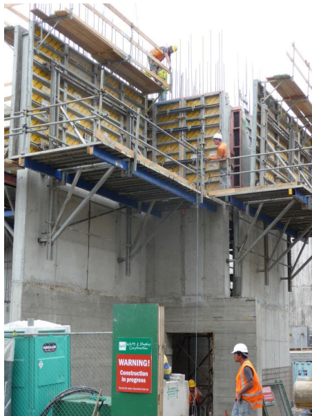
Figura 2. Gjatë projektimit dhe ndërtimit, këto mure betoni të armuar u kontrolluan nga inxhinierët për të siguruar që projekti strukturor ishte i sigurt dhe se ndërtimi ishte në përputhje me planet.
