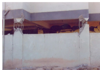
Figure 4. Kolonë e shkurtër e dëmtuar nga tërmeti.
