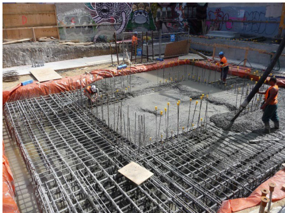
Figura 3. Themelet e një ndërtese në ndërtim. Inxhinierët kanë ndjekur kodet për të përcaktuar sasinë e çelikut përforcues dhe vendndodhjen e saktë të tij.
