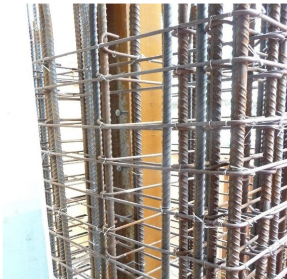
Figura 3. Armimi i kolonës është i dukshëm përpara hedhjes së betonit. Armatura përbëhet nga shufra vertikale që i rezistojnë përkuljes dhe stafa që ndalojnë betonin e kolonës nga shpërbërja dhe zhvendosja.
