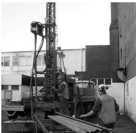
Figura 3. Një pajisjeje shpimi në një truall, për marrjen e mostrave dhe testimin e tyre në laborator.
