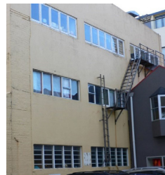
Figura 2. Kolonat me lartësi normale janë shkurtuar, nga këndvështrimi i rezistencës ndaj forcave horizontale, nga muret mbushës me lartësi të pjesshme.
