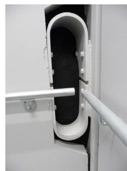
Figura 7. Një absorbues i energjisë së tërmetit i vendosur midis dy mure lëkundëse.
