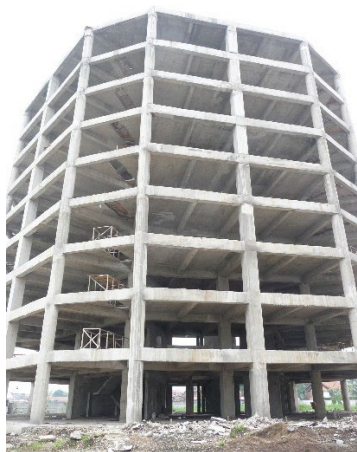
Figura 1. Këto dy ndërtesa u rezistojnë tërmeteve përmes fortësisë së kolonave dhe trarëve të tyre. Muret dhe veshja ende nuk janë ndërtuar.
