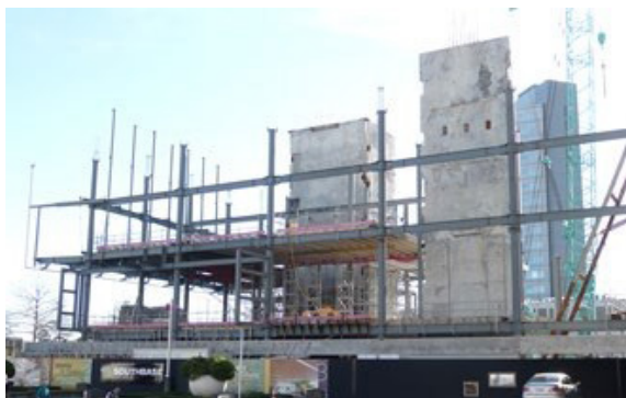
Figura 3. Një ndërtesë në ndërtim. Shumica e forcave të tërmetit në të dy drejtimet përballohen nga muret strukturore të betonit të armuar. Në këtë rast, një farë ndihme ofrohet gjithashtu nga një rame momenti çeliku në perimetër.
