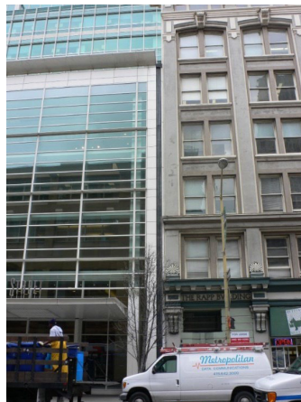
Figura 4. Dy ndërtesa të ndara nga një fugë sizmike i mbuluar nga një material fleksibël maskues.
