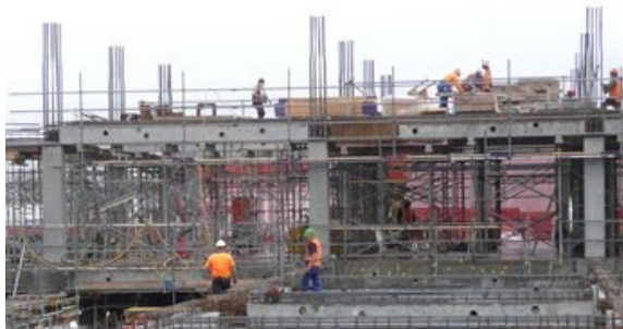
Figura 3. Një inxhinier duhet të vizitojë rregullisht kantiere si kjo për të siguruar që ndërtimi është në përputhje me planet dhe specifikimet.
