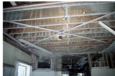
Figure 5. Dysheheja prej druri e një ndërtese prej murature është përforsuar për rezistencë ndaj tërmetit me kontraventime çeliku nën të.
