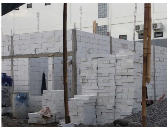
Figura 3. Rregulloret e ndërtimit duhet të specifikojnë mënyra të sigurt por praktike të përdorimit të materialeve të reja, të tilla si këto blloqe me peshë të lehtë.
