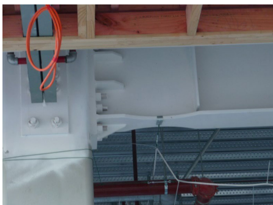
Figura 1. Një ndërtim në ndërtim me një kolonë në të majtë dhe një tra çeliku të lidhur me të. Vini re se si pllaka e poshtme (flanxha) e traut pranë kolonës është zvogëluar në madhësi. Kjo zonë e dobësimi të qëllimshëm do të jetë vendi ku një çernierë plastike do të formohet në një tërmet të madh. Çeliku në këtë rajon do të zgjatet, por nuk do të shkatërrohet.
