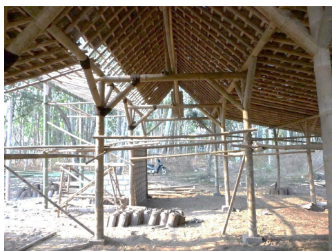
Figura 1. Një ndërtesë shumë fleksibël gjatë lëkundjeve horizontale. Materialet dhe metodat tradicionale të ndërtimit janë përfshirë në një ndërtesë të re tradicionale indoneziane.
