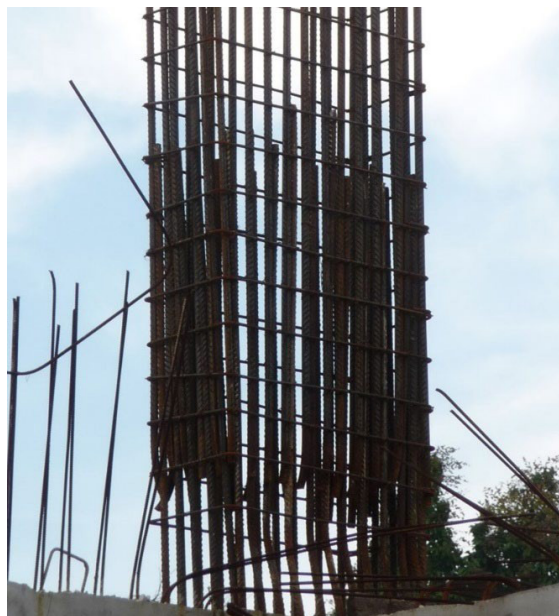
Figura 2. Përforcimi i kësaj kolone nuk përputhet në shumë mënyra me kodet dhe standardet lokale. Gjatë një tërmeti mesatar deri në të madh, ajo do të dëmtohet rëndë.
