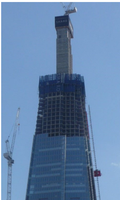
Figura 3. Një shembull i një bërthame betoni të armuar në një ndërtesë në ndërtim.
