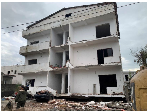
Figura 4. Kjo ndërtesë me kate të buta humbi katin përdhe gjatë një tërmeti të moderuar (N. Vesho).
