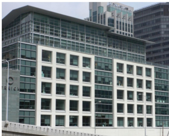
Figure 3. Dy rama moment me katër hapësira rezistente ndaj forcës së tërmetit veprojnë përgjatë ndërtesës. Të njëjtat rama duhet të jenë dhe në anën tjetër të ndërtesës.
