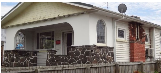
Figura 3. Një oxhak prej tulle ka rënë nga niveli i çatisë. Pjesa më e madhe e oxhakut të mbetur është e dëmtuar (N. Allaf).
