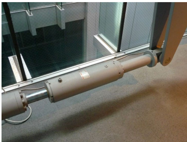
Figura 3. Një amortizues për të reduktuar lëvizjet e tërmeteve.
