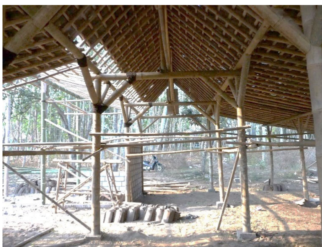
Figura 1. Një ndërtesë shumë fleksibël gjatë lëkundjeve horizontale. Materialet dhe metodat tradicionale të ndërtimit janë përfshirë në një ndërtesë të re tradicionale indoneziane.
