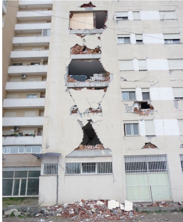
Figura 2. Një shembull i një ndërtese të dëmtuar nga tërmeti ku muret e mbushjes nuk janë projektuar me kujdes për të lejuar forcat dhe lëvizjet gjatë një tërmeti.
