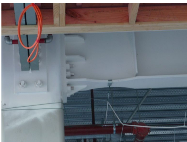
Figura 1. Një ndërtesë në ndërtim me një kolonë në të majtë dhe një tra çeliku të lidhur me të. Vini re se si pllaka e poshtme (flanaxha) e traut pranë kolonës është zvogëluar në madhësi. Kjo zonë e dobësimi të qëllimshëm do të jetë vendi ku një çernierë plastike do të formohet në një tërmet të madh. Çeliku në këtë rajon do të zgjatet, por nuk do të shkatërrohet.
