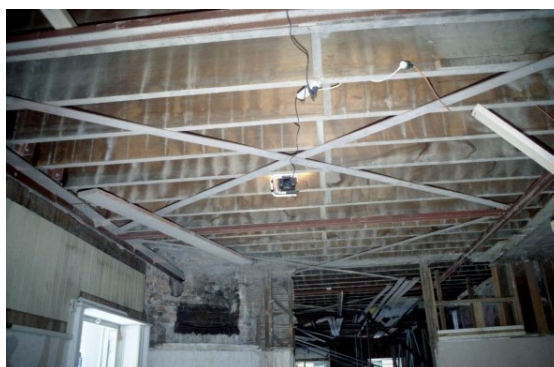
Figure 5. Dyshemeja prej druri e një ndërtese prej murature është përforcuar për rezistencë ndaj tërmetit me kontraventime çeliku nën të.
