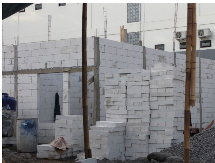
Figura 3. Rregulloret e ndërtimit duhet të specifikojnë mënyra të sigurt por praktike të përdorimit të materialeve të reja, të tilla si këto blloqe me peshë të lehtë.
