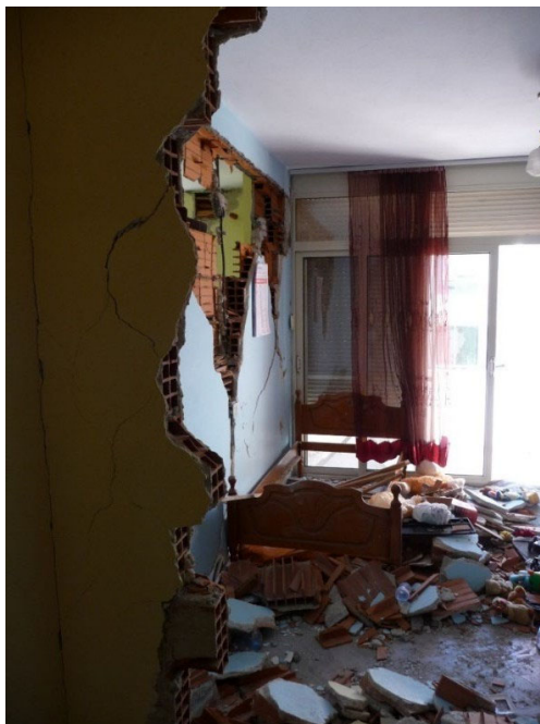
Figura 2. Muret e dëmtuara nga lëkundjet e tërmetit paraqesin rrezik për jetën.
