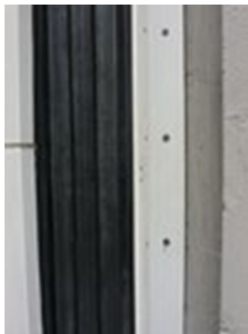
Figura 5. Një pamje nga afër e material fleksibël maskues që mbulon hapësirën sizmike.
