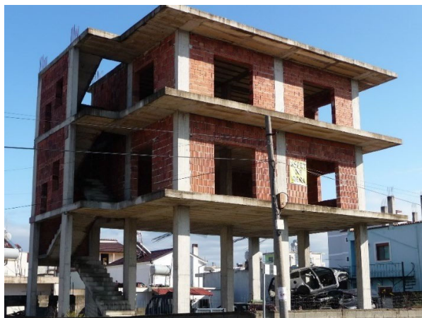
Figura 5. Një ndërtesë tipike me kate të buta ku kati përdhe është më i dobëti.
