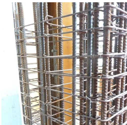
Figura 3. Armimi i kolonës është i dukshëm përpara hedhjes së betonit. Armatura përbëhet nga shufra vertikale që rezistojnë përkuljes dhe stafa që ndalojnë betonin e kolonës nga shpërbërja dhe zhvendosja.
