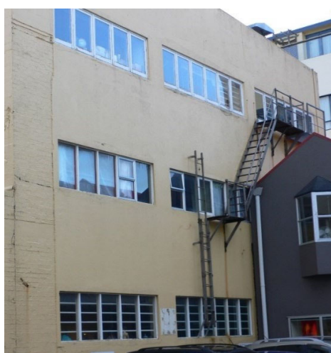
Figura 2. Kolonat me lartësi normale janë shkurtuar, nga këndvështrimi i rezistencës ndaj forcave horizontale, nga muret mbushëse me lartësi të pjesshme.
