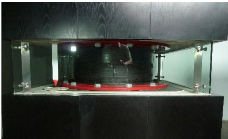
Figura 4. Një kushinetë gome rrethore që përmban shumë pllaka të holla çeliku ndodhet midis fundit të çdo kolone dhe themelit të saj për të izoluar ndërtesën nga lëkundjet horizontale të tërmeteve.
