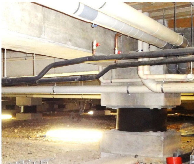
Figura 2. Dy izolatorët elasto-merik të zeza dhe cilindrike nën një ndërtesë. Çdo izolator elasto-merik është vendosur me ngjitje në një bazë betoni në nivelin midis themelit dhe kolonës që ngrihet lart në ndërtesë.
