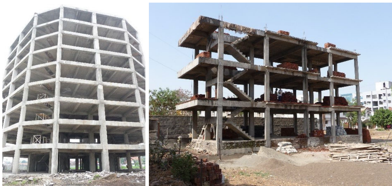
Figura 1. Këto dy ndërtesa u rezistojnë tërmeteve përmes fortësisë së kolonave dhe trarëve të tyre. Muret dhe veshja ende nuk janë ndërtuar.
