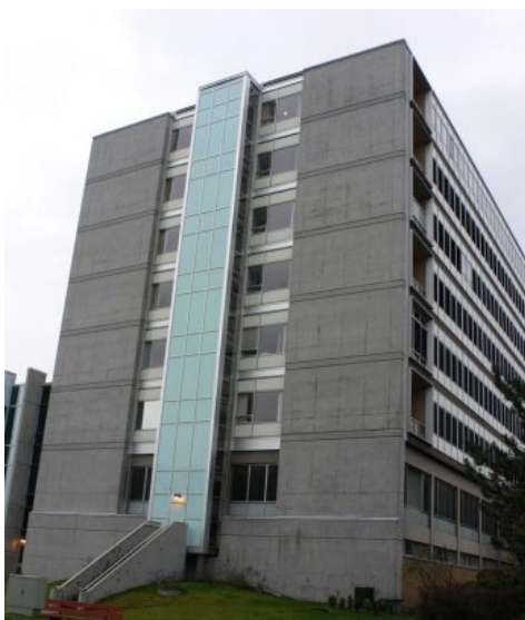
Figura 2. Rikonstruksioni sizmik i kësaj godine spitalore përfshinte dy mure të reja strukturorë dhe themele në çdo skaj.
