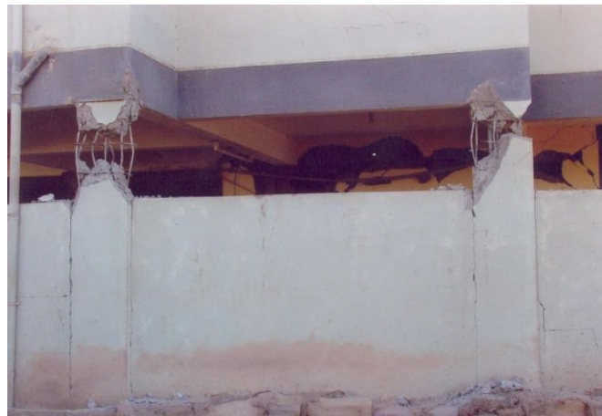
Figure 4. Kolonë e shkurtër e dëmtuar nga tërmeti.
