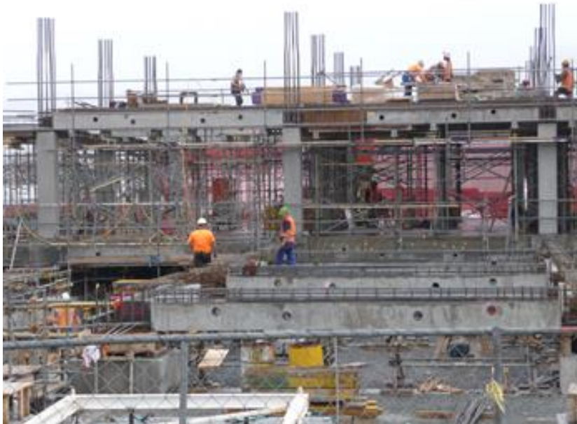
तस्वीर 3. निर्माण कार्य के दौरान एक अभियंता को बार-बार निर्माण क्षेत्र पर जाना चाहिए। इससे ये सुनिश्चित किया जा सकता है कि निर्माण योजना एवं मानकों के अनुरूप है।
