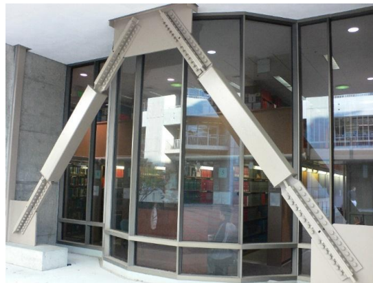
तस्वीर 5. दो बकलिंग रेस्ट्रेंड ब्रेस (buckling-restrained brace) भूकंपीय बलों का प्रतिरोध करने के साथ में मकान में होने वाले कम्पन को अवमंदित (damp) करते हैं।
