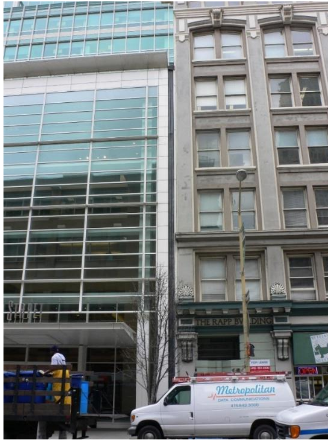
तस्वीर 4. दो मकानों के बीच अंतर ( seismic separation gap ) में एक मुलायम पदार्थ।
