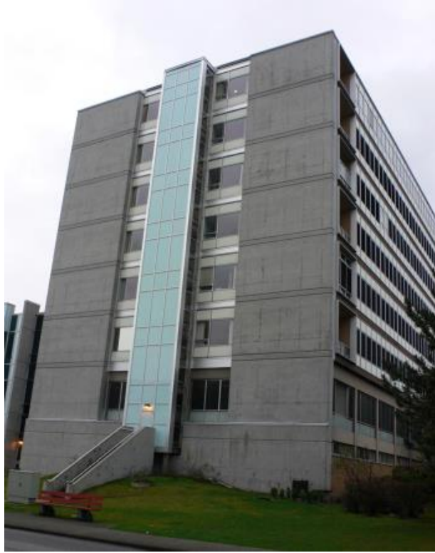
तस्वीर 2. इस अस्पताल की रेट्रोफिट में दोनों दिशाओं में दो नयी संरचनात्मक दीवारें और उनकी आधारशिलाएँ (foundations) बनायी गयीं।
