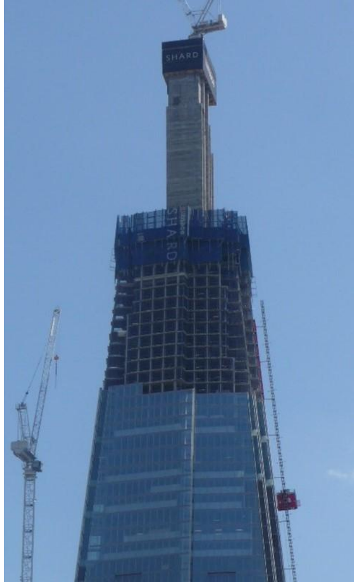
तस्वीर 3. एक प्रबलित कंक्रीट (reinforced concrete) के केंद्रीय ढाँचे वाली निर्माणाधीन इमारत ।
