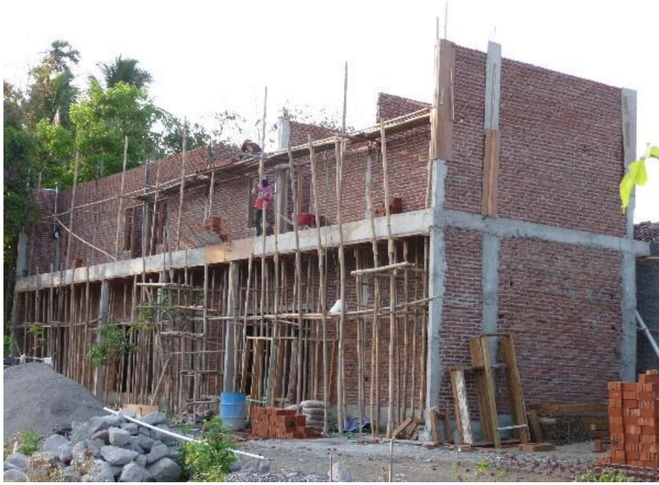
तस्वीर 2. एक निर्माणाधीन संकुचित चिनाई (confined masonry) भवन ।
