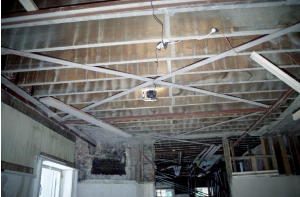
तस्वीर 5. इस ईंट की दीवार में लकड़ी के तल को स्टील के ब्रेस लगा के मज़बूती प्रदान की गयी है।
