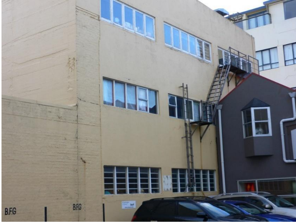
तस्वीर 2. सामान्य ऊँचाई के स्तंभ (column) आधी ऊँचाई की दीवारों की वजह से छोटे हो गए हैं। इसका प्रभाव इन स्तंभों की भूकंपरोधी क्षमता पर पड़ता है।
