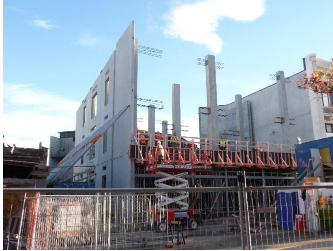
तस्वीर 2. इस मकान में पूर्वप्रतिबलित कांक्रीट (prestressed concrete) का नए तरीके से इस्तेमाल हुआ है।
