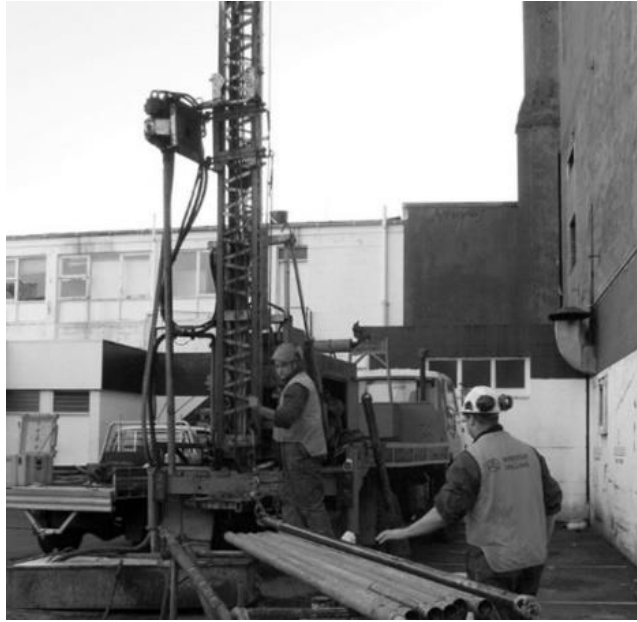
तस्वीर 3. प्रयोगशाला परीक्षण के लिए मिट्टी के नमूने लिए जा रहे हैं।
