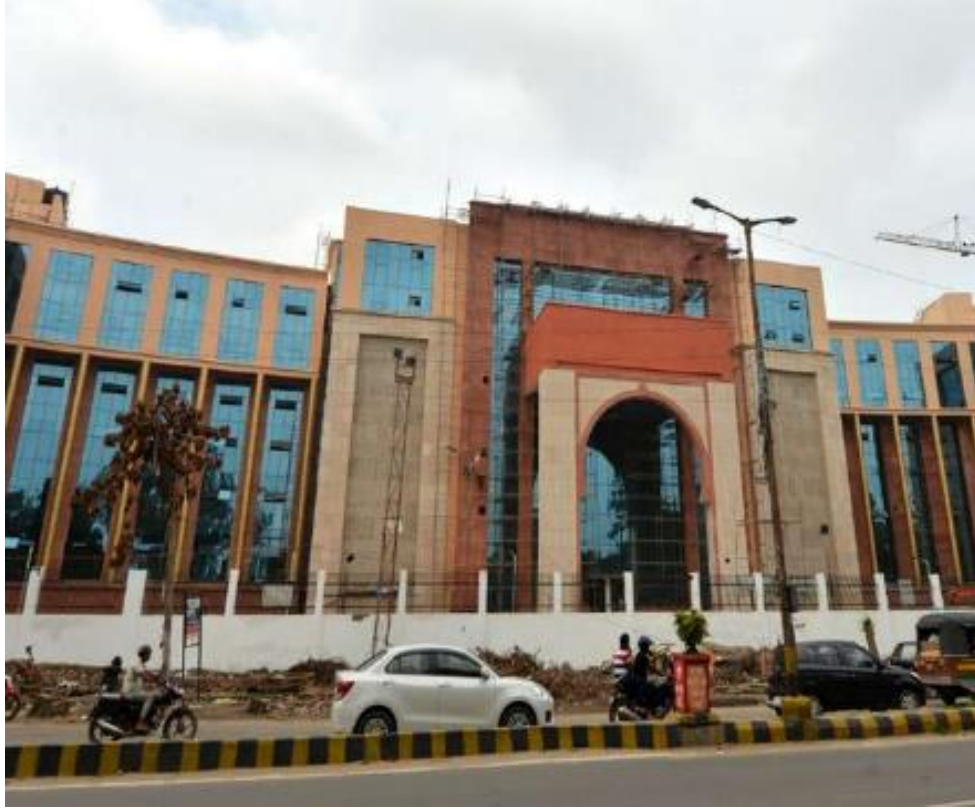
तस्वीर 3. बिहार के पटना में भूकंपीय पृथक्करण (seismic isolation) तकनीक से बना पुलिस मुख्यालय (source: https://www.jagran.com/bihar/patna-city-bihar-police-hq-shifted-in-its-new-hightech-building-know-its-specialities-jagran-special-18522551.html )
