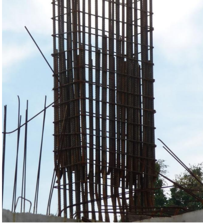
तस्वीर 2. इस स्तंभ (column) की छड़ें कई मायनों में संहिताओं और मानकों के अनुरूप नहीं हैं। एक मध्यम अथवा बड़े भूकंप के दौरान इसमें गंभीर क्षति की काफी संभावना है।
