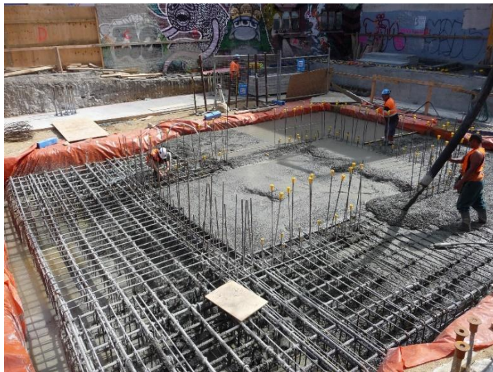
तस्वीर 3. एक निर्माणाधीन मकान की आधारशिला। अभियंताओं ने संहिताओं का उपयोग प्रबलन (reinforcing) स्टील के परिमाण और उनकी सही जगह तय करने के लिए किया है।
