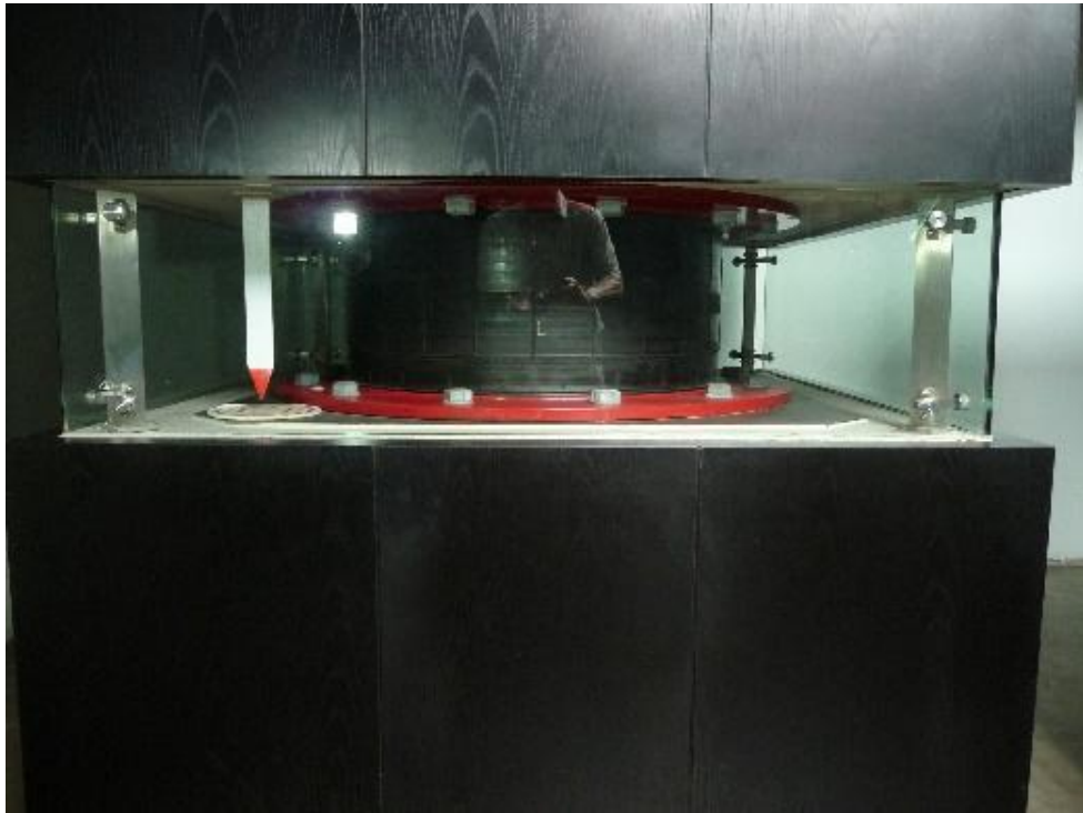
तस्वीर 4. एक वृत्ताकार (circular) रबड़ बेयरिंग (bearing) में कई सारे पतले स्टील प्लेट होते हैं। हर प्लेट के ऊपर और नीचे रबड़ की पट्टी होती है। इस तरह के उपकरण मकान में हर स्तंभ के नीचे डाल कर मकान को भूकंप से क्षैतिज (horizontal) दिशाओं में पृथक (isolate) किया जा सकता है।
