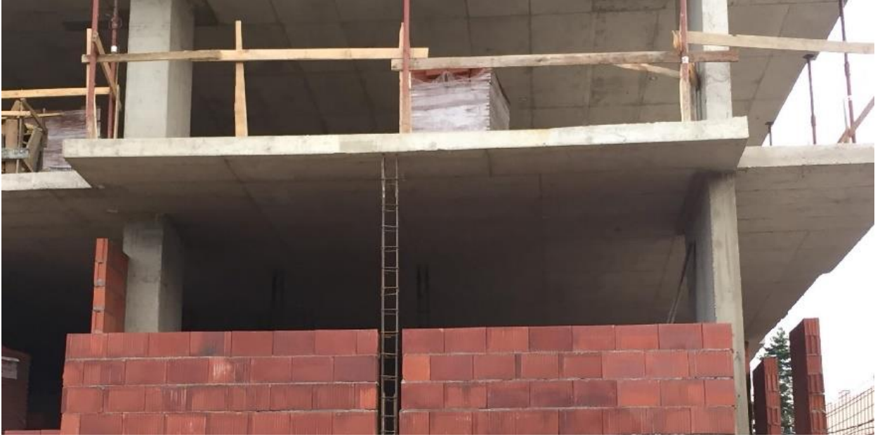
तस्वीर 4. एक दीवार को स्थिरता प्रदान करने के लिए एक टाई कॉलम का उपयोग (S. Brzev) ।
