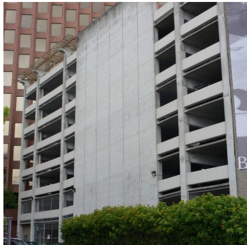
तस्वीर 5. एक प्रबलित कांक्रीट (reinforced concrete) संरचनात्मक दीवार (structural wall) एक दिशा में भूकंप का प्रतिरोध करेगी। ऐसी ही एक दीवार मकान की दूसरी तरफ भी होनी चाहिए।
