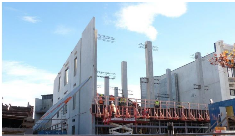
شکل ۳. مثال‌های نوآورانه‌ای از کاربرد بتن پیش ساخته در یک ساختمان.
