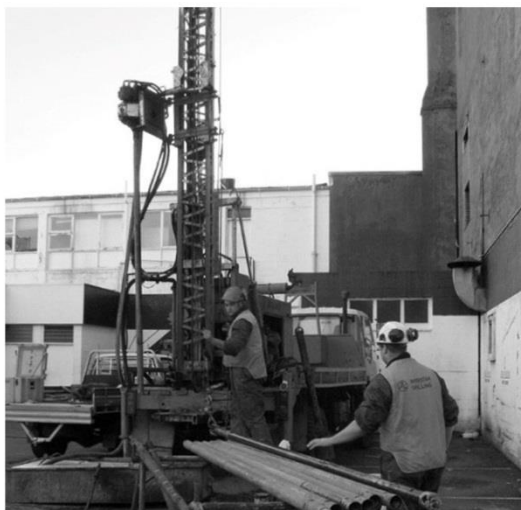
شکل ۵: سکوی حفاری نمونه برداری خاک برای بررسی در آزمایشگاه.
