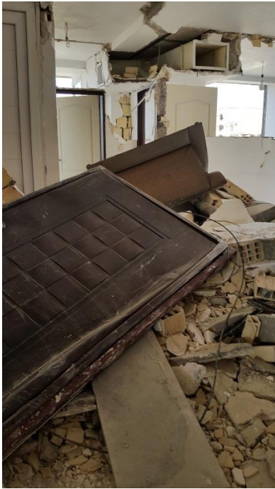
شکل ۴. دیوارها و اجزا غیرسازه‌ای آسیب دیده در زلزله ۱۲ نوامبر ۲۰۱۷ سرپل ذهاب- ازگله کرمانشاه، ایران ( M_w = 7.3 ) (ب. حسینی هاشمی ۳ ).
