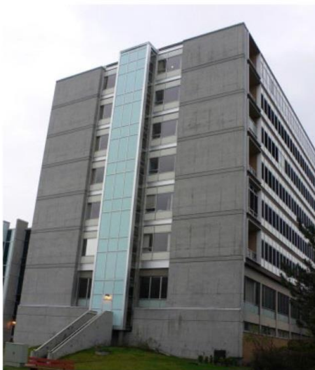
شکل ۲. مقاومسازی لرزه‌ای ساختمان این بیمارستان شامل دو دیوار سازه‌ای جدید و پی در هر انتها می‌باشد.
