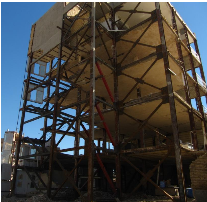
شکل ۶. استفاده از مهاربندهای کمانش تاب در مقاومسازی ساختمان‌های آسیب دیده در زلزله ۱۲ نوامبر ۲۰۱۷ سرپل ذهاب- ازگله کرمانشاه، ایران ( M_w = 7.3 ) (ب. حسینی هاشمی ۲ ).
