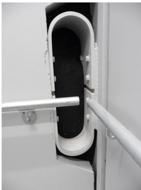
شکل ۷. جاذب انرژی زلزله که بین دو دیوار گهواره‌ای قرار داده شده است.
