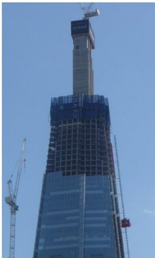
شکل ۳. مثالی از یک هسته بتن مسلح در ساختمانی در حال ساخت.
