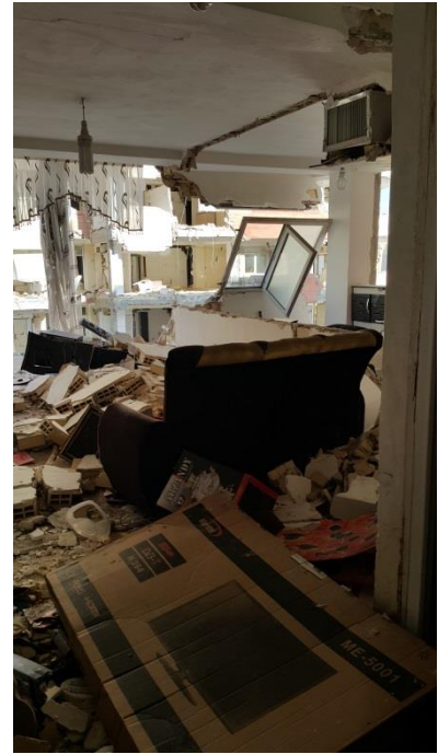
شکل ۴. دیوارها و اجزا غیرسازه‌ای آسیب دیده در زلزله ۱۲ نوامبر ۲۰۱۷ سرپل ذهاب- ازگله کرمانشاه، ایران ( M_w = 7.3 ) (ب. حسینی هاشمی ۳ ).
