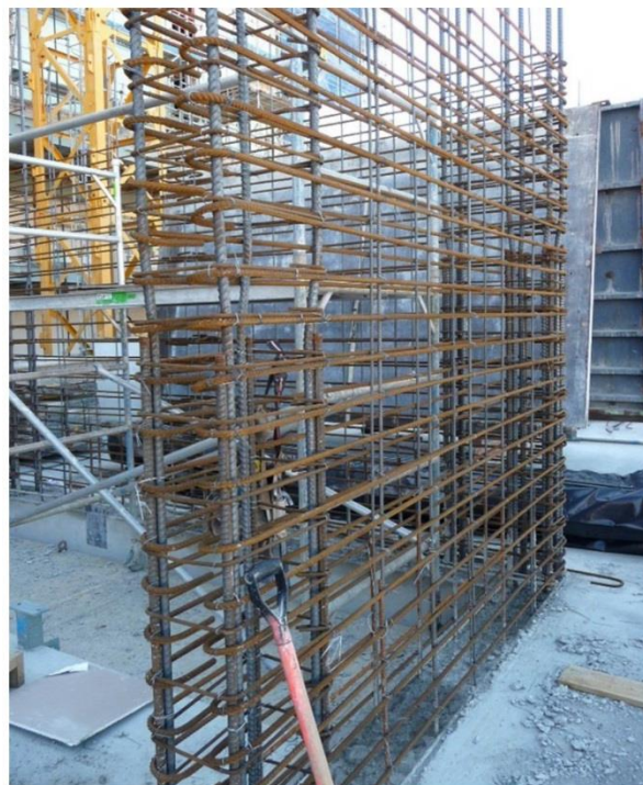
شکل ۱. فقدان چند میلگرد تقویتی در این دیوار بتن مسلح، می‌تواند منجر به وقوع آسیب شدید در هنگام وقوع زلزله شود.
