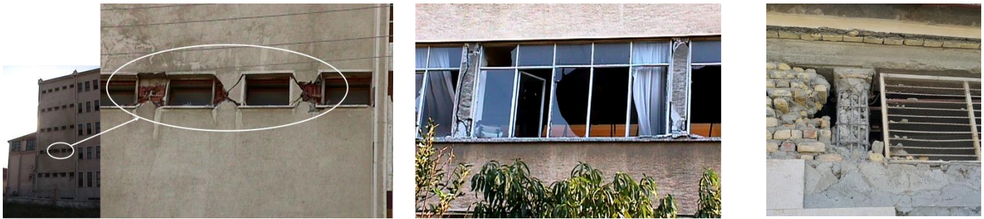
شکل ۵. ستون‌های کوتاه آسیب دیده در زلزله‌های اخیر ایران و جهان (ب. حسینی هاشمی ۲ ).
