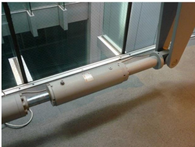
شکل ۳. یک میراگر برای کاهش حرکات لرزه‌ای.
