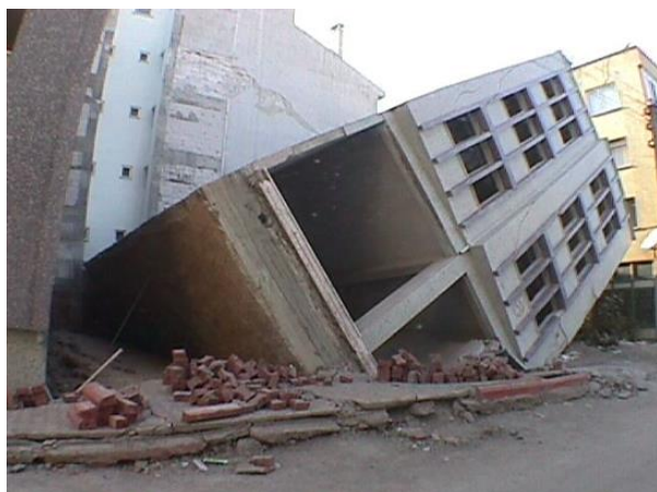
شکل ۴: نمونه‌هایی از روانگرایی خاک در زلزله هفدهم آگوست ۱۹۹۹ از میت ترکیه و کج شدگی ساختمان‌ها (ب. حسینی هاشمی ۳ ).
