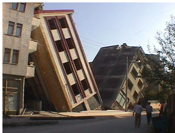
شکل ۴: نمونه‌هایی از روانگرایی خاک در زلزله هفدهم آگوست ۱۹۹۹ از میت ترکیه و کج شدگی ساختمان‌ها (ب. حسینی هاشمی ۳ ).
