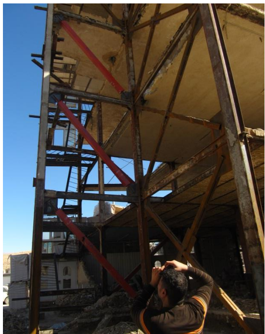
شکل ۶. استفاده از مهاربندهای کمانش تاب در مقاومسازی ساختمان‌های آسیب دیده در زلزله ۱۲ نوامبر ۲۰۱۷ سرپل ذهاب- ازگله کرمانشاه، ایران ( M_w = 7.3 ) (ب. حسینی هاشمی ۲ ).
