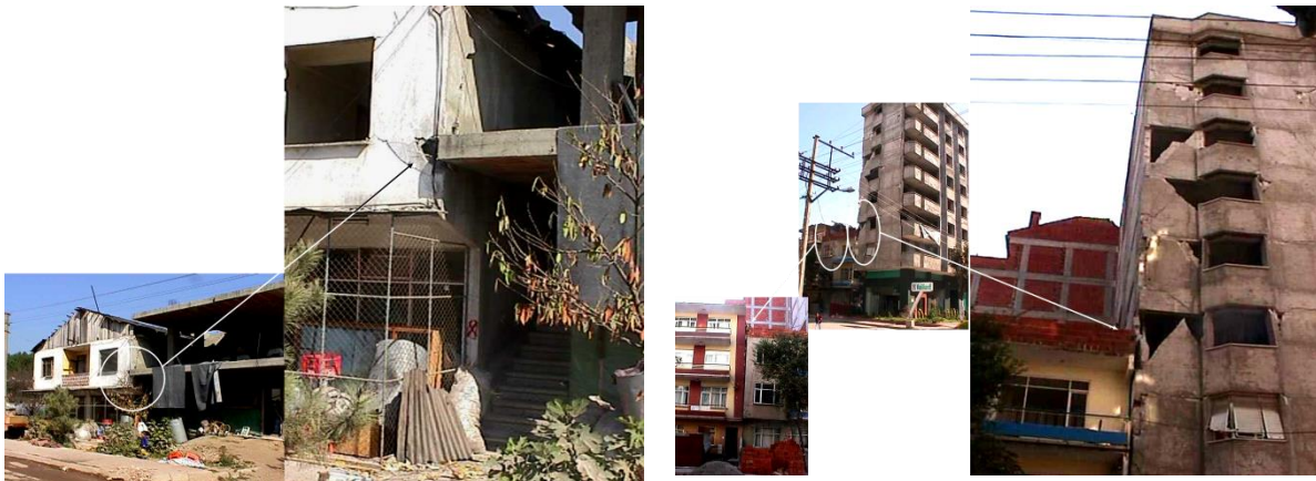
شکل ۲. ضربه ساختمان‌های مجاور در زلزله ۱۷ آگوست ۱۹۹۹ از میت ترکیه (ب. حسینی هاشمی ۲ ).
