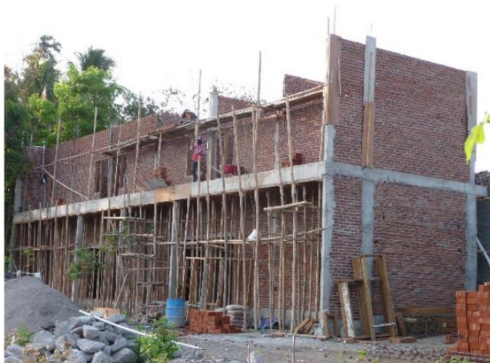
شکل ۲. خانه‌ای در حال ساخت با سیستم بنایی محصور شده.
