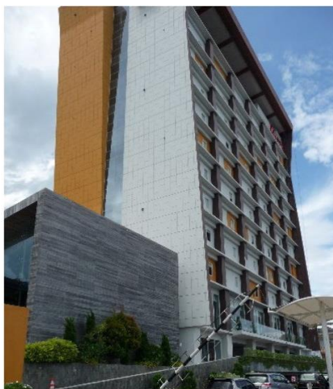
شکل ۳. هتل Ibis، پادانگ، اندونزی که دارای سیستم جداساز پایه می باشد.
