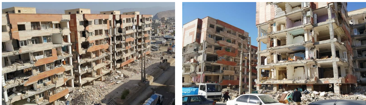
شکل ۳. دیوارهای میان قاب آسیب دیده در زلزله ۱۲ نوامبر ۲۰۱۷ سرپل ذهاب- ازگله کرمانشاه، ایران ( M_w = 7.3 ) (ب. حسینی هاشمی ۳ ).
