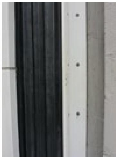
شکل ۶. نمای نزدیک از درزگیر برای پوشاندن درز انقطاع لرزه‌ای.
