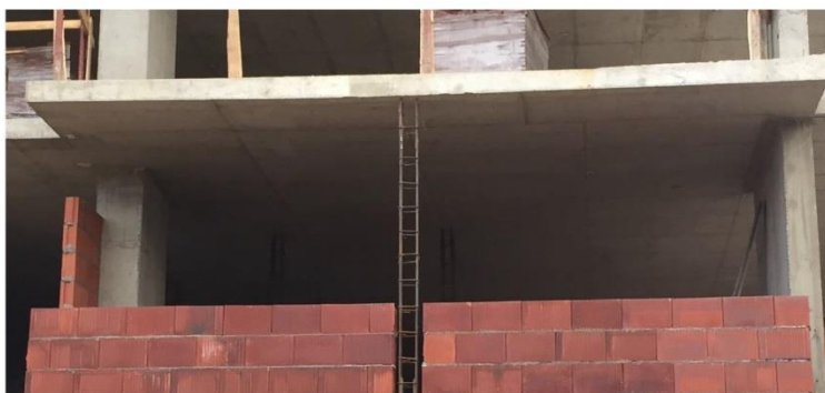
شکل ۵. مثالی از اجرای ستون میانی برای تثبیت یک دیوار بنایی (اس. برژو ۴ )
