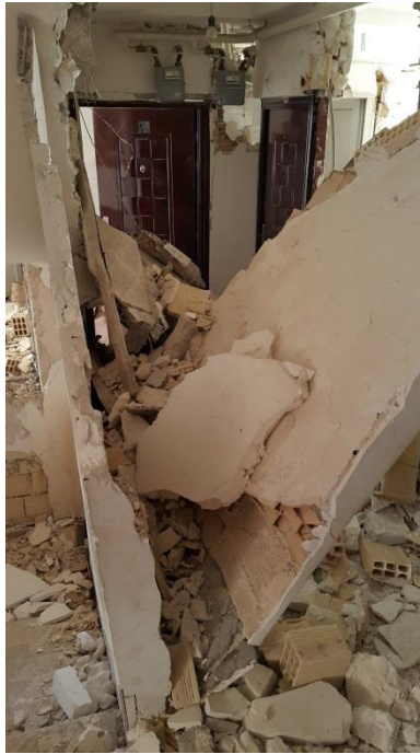
شکل ۴. دیوارها و اجزا غیرسازه‌ای آسیب دیده در زلزله ۱۲ نوامبر ۲۰۱۷ سرپل ذهاب- ازگله کرمانشاه، ایران ( M_w = 7.3 ) (ب. حسینی هاشمی ۳ ).
