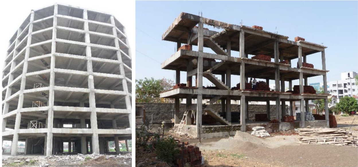
شکل ۱. این دو ساختمان زلزله‌ها را از طریق مقاومت ستون‌ها و تیرها تحمل می‌کنند. دیوارها و نماها هنوز ساخته نشده‌اند.
