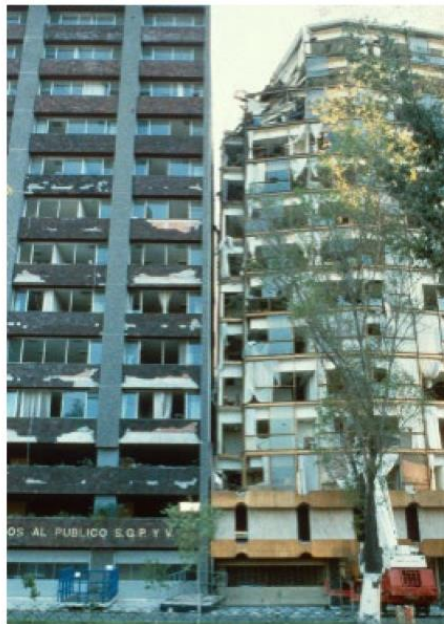
شکل ۳. دو ساختمان که به یکدیگر ضربه زده‌اند و یکی از آن‌ها خیلی بیش از دیگری آسیب دیده است.
