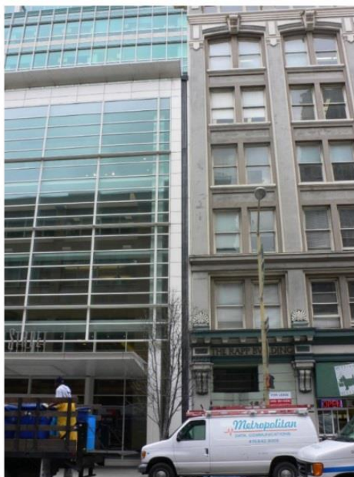
شکل ۵. دو ساختمان جدا شده توسط یک درز انقطاع لرزه‌ای پوشیده شده با درزگیرهای انعطاف‌پذیر.
