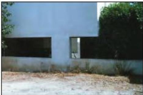
**Figura 17. Un edificio con columnas cortas en el nivel de sótano en Chipre (fuente: Levtchitch 2002).**
