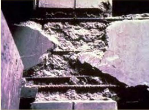
Figura 43. Falla a cortante de una unión viga-columna de CR durante el sismo de 1985 en Ciudad de México, debido a que las barras de refuerzo de la viga se colocaron afuera de la armadura de la columna (fuente: EERI 2000).
