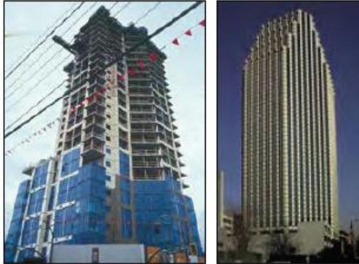
**Figura 4. Ejemplos de rascacielos de CR en Canadá (izquierda; de Pao y Brzev 2002), y Chile (derecha, de Moroni y Gómez 2002). Muros de cortante de CR proporcionan resistencia a los efectos sísmicos en estos edificios mientras que las columnas se diseñan para resistir las cargas gravitacionales.**
