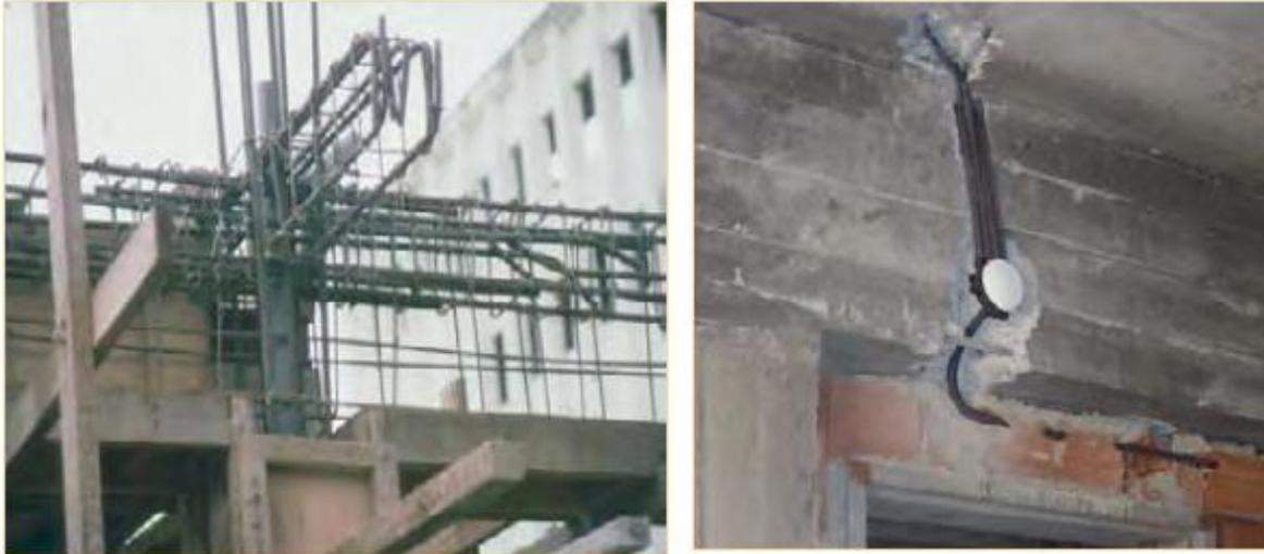
Figura 51. Ejemplos de malas prácticas constructivas: (a) instalación inaceptable de tuberías a través de la armadura de la columna, y (b) instalación inaceptable de conductos eléctricos por el daño ocasionado a la viga de CR existente (fotos: A. Irfanoglu).
