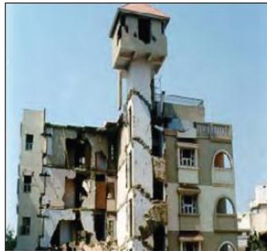
Figura 6. Un edificio con una forma bastante irregular sufrió graves daños en el sismo de 2001 en Bhuj, India (fuente: EERI 2001).
