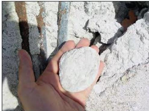
**Figura 53. Tamaño de agregado inapropiado; Nótese el concreto de baja calidad, altamente poroso, y las barras corroidas y lisas (foto: A. Irfanoglu).**
