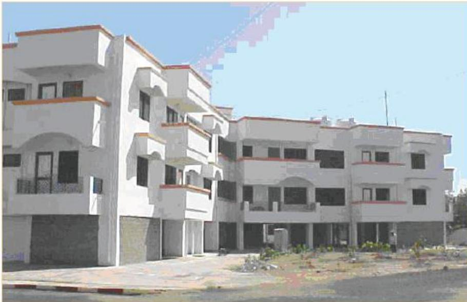
**Figura 76. Una solución de corto plazo a la vulnerabilidad sísmica de un edificio con planta baja abierta, después del sismo de 2001 en Bhuj; notar que las aberturas en la planta baja se rellenaron con muros de mampostería nuevos (foto: C.V.R. Murty).**
