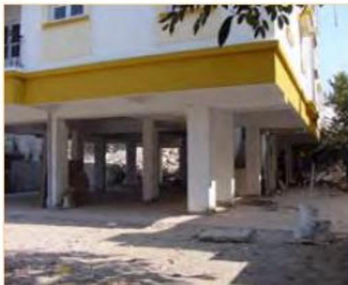
Figura 24. Edificio típico con planta baja débil en India (fuente: ERRI 2001).
