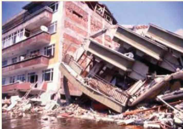
**Figura 32. Colapso de varios pisos en un edificio de seis pisos debido al diseño de columna débil – viga fuerte en el sismo de 1999 en Turquía (fuente: Gulkan et al. 2002).**
