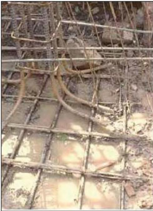
**Figura 56. Mal trabajo constructivo: suciedad en área de trabajo y anclaje inapropiado de las barras de la columna (fuente: Mejía 2002).**
