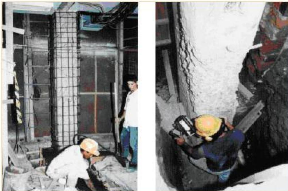
Figura 69. Instalación de revestimientos de concreto reforzado desde el nivel de la fundación hasta la parte inferior de la viga; ejemplos de Colombia (fuente: Mejía 2002).
