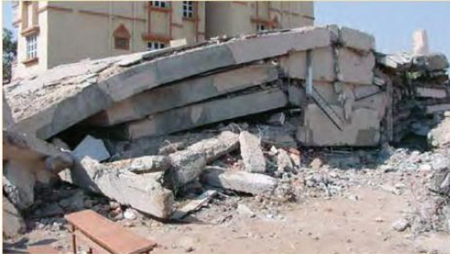
**Figura 31. Colapso de un edificio de marcos de CR de varios pisos debido al diseño de columna débil – viga fuerte en el sismo de 2001 en Bhuj, India (foto: C. V. R. Murty).**
