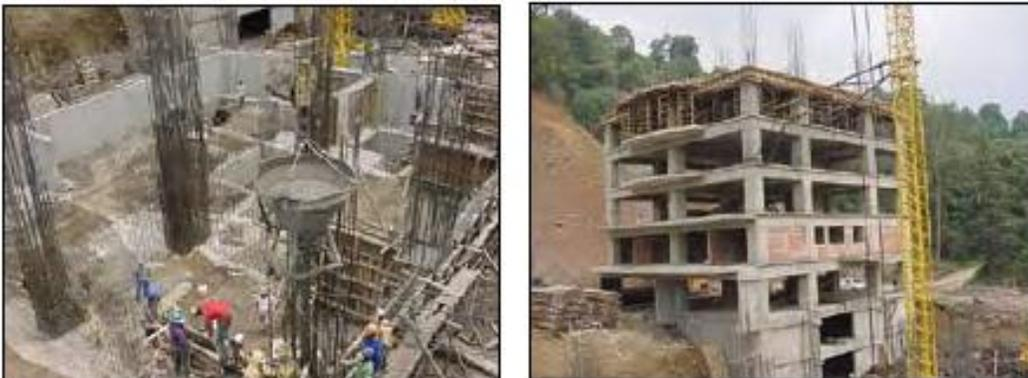
**Figura 5. Un ejemplo de construcción de marcos de CR de México (fuente: Rodríguez y Jarque 2005): colocación del refuerzo de columna (izquierda) y el marco completo con rellenos (derecha).**
