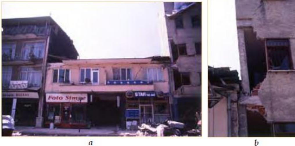
Figura 23. (a) Martilleo entre un edificio de seis pisos y uno de dos pisos en Golcuk, Turquía causando daños en las columnas del edificio de seis pisos durante el sismo de 1999; (b) Detalle del daño por martilleo en un edificio de seis pisos mostrado en la figura (a) (fuente: Gulkan et al. 2002).
