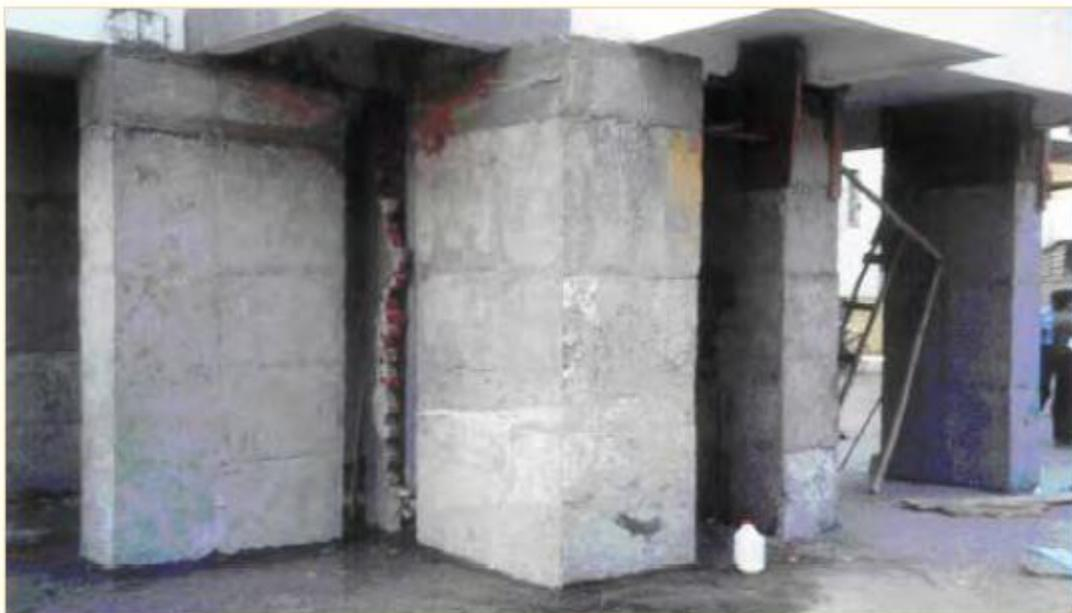
Figura 73. Un ejemplo de una práctica de refuerzo inapropiada: el encamisado de las columnas de CR resultó en tamaños de columnas extremadamente grandes (notar la ausencia de continuidad con respecto al nivel superior y a las fundaciones) (foto: C.V.R. Murty).
