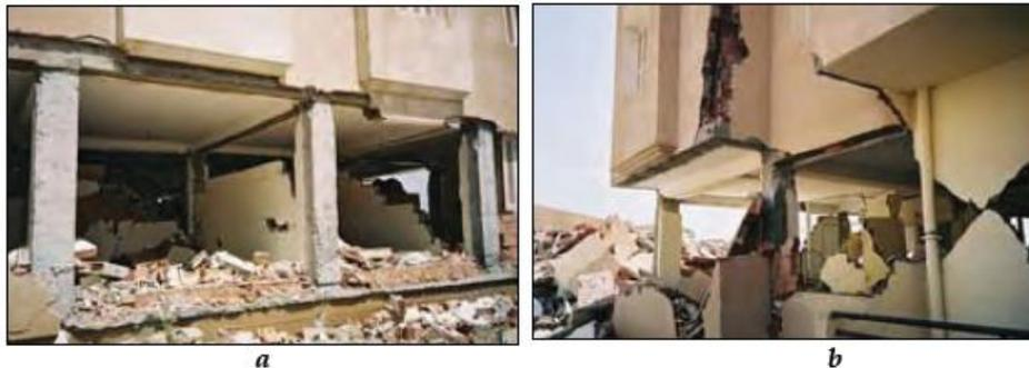
**Figura 15. Edificio de marcos de CR con paredes de relleno de mampostería en Argelia (después del sismo de 2003 en Boumerdes): (a) Los muros de relleno de mampostería fallaron en ambas direcciones; (b) Falla de muro de relleno de mampostería que muestra agrietamiento diagonal debido a la acción de puntal en compresión (fotos: S. Brzev).**
