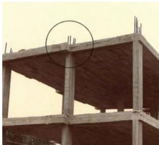
**Figura 37. Inadecuada longitud de traslape y ubicación para futuras construcciones – el 100% de los traslapes está en la base de la columna (fuente: Mejía 2002).**
