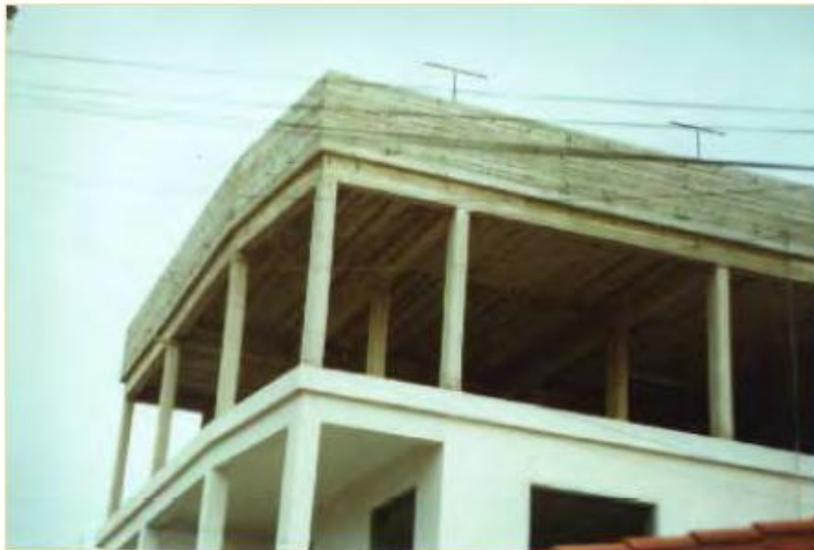
Figura 21. Un ejemplo de un edificio de marcos de CR existente en Chipre mostrando columnas débiles, marco incompleto y un pesado y rígido parapeto (fuente: Levitchich 2002).
