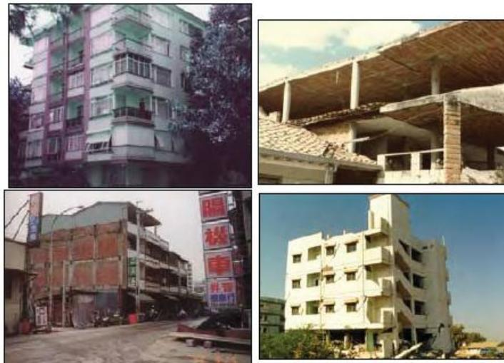
**Figura 3. Construcciones de marcos de CR de baja y mediana altura: Turquía (arriba izquierda; de Gulkan et al. 2002); Colombia (arriba derecha; de Mejía 2002); Taiwán (abajo izquierda; de Yao y Sheu 2002); India (abajo derecha; de Jaiswal et al. 2002)**
