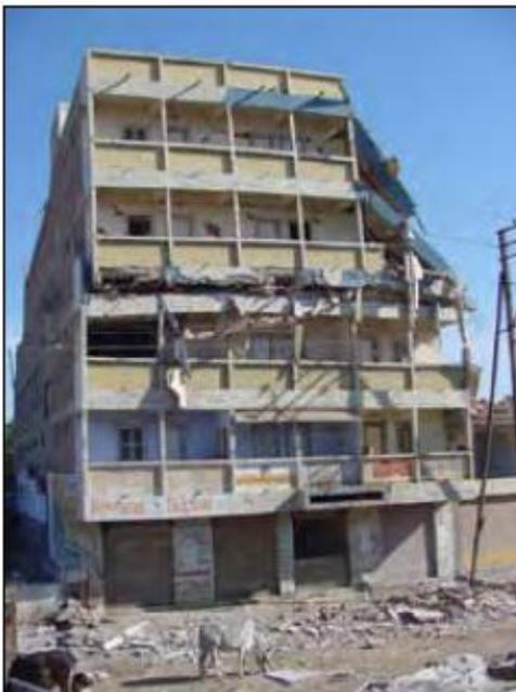
Figura 26. Un ejemplo de colapso de un edificio debido a un piso suave intermedio en el sismo de 2001 en Bhuj, India (fuente: EERI 2001).
