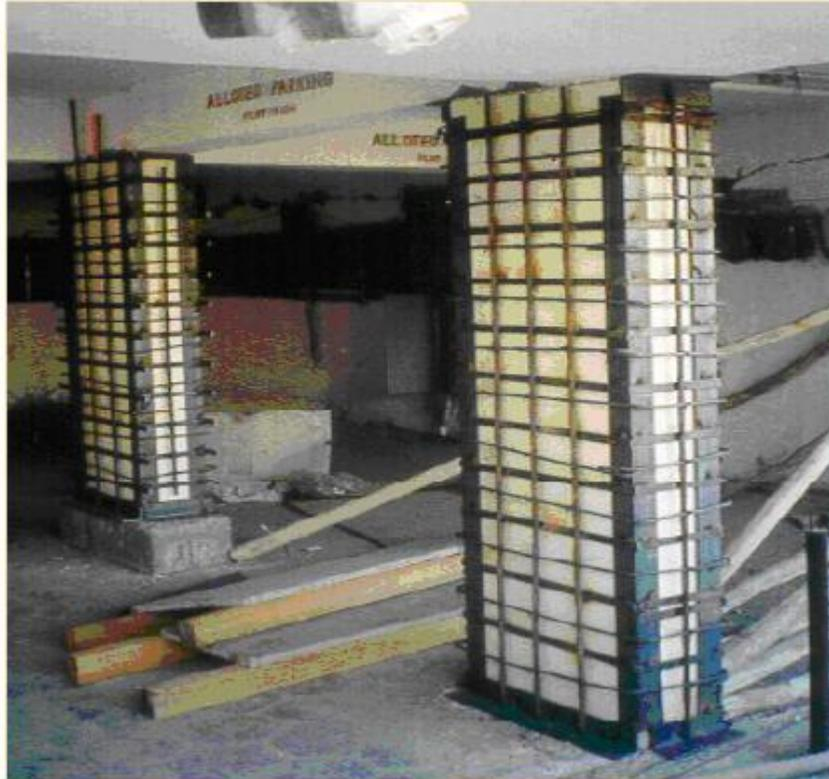
Figura 72. Un ejemplo de encamisado inadecuado en acero: angulares de acero verticales asegurados con barras de refuerzo horizontal soldado, seguidos por la colocación del concreto; los listones no continúan hasta las vigas del nivel superior ni empiezan desde el nivel de la fundación. El encamisado se limita al nivel inferior (foto: C.V.R. Murty).
