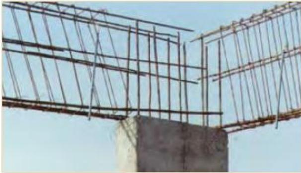
Figura 44. Detallado inapropiado del refuerzo de una unión viga-columna en India: las barras de refuerzo de la viga son discontinuas en la unión; se requiere que estas barras sean continuas y que aporten confinamiento al concreto en la zona de la unión (notar la ausencia de estribos en la unión) (fuente: Jaiswal et al. 2002).
