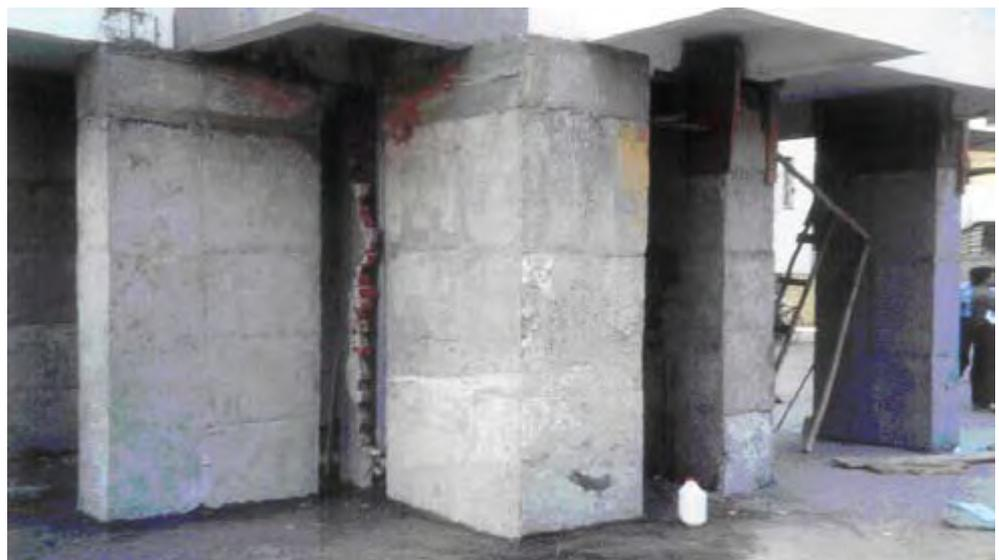
**Gambar 73.** Sebuah contoh praktik perkuatan yang kurang tepat: pelapisan (jacketing) kolom beton bertulang menyebabkan ukuran dimensi kolom menjadi sangat besar (perhatikan ketiadaan kontinuitas antara lantai-lantai atas dan fondasi) (foto: C.V.R. Murty).
