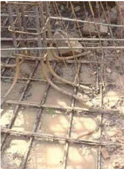
**Gambar 56.** Kualitas pekerja yang buruk: pekerjaan tanah yang kotor dan tulangan kolom serta pengangkurannya yang kurang tepat (sumber: Mejia 2002).
