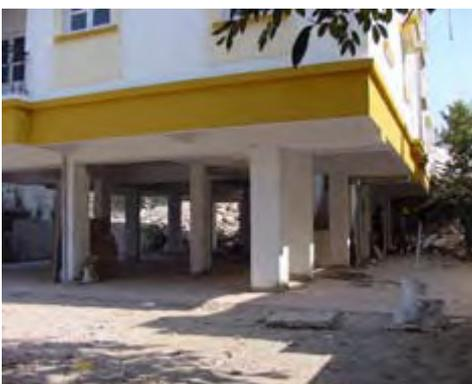
**Gambar 24.** Bangunan tipikal dengan sebuah tingkat dasar yang “lunak” di India (sumber: EERI 2001).
