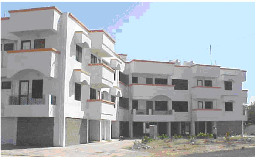
**Gambar 76.** Solusi jangka pendek bagi kerentanan seismik sebuah bangunan dengan tingkat dasar terbuka setelah gempa Bhuj 2001: perhatikan bidang bentangan yang terbuka pada tingkat dasar diisi dengan dinding bata baru (foto: C.V.R. Murthy).
