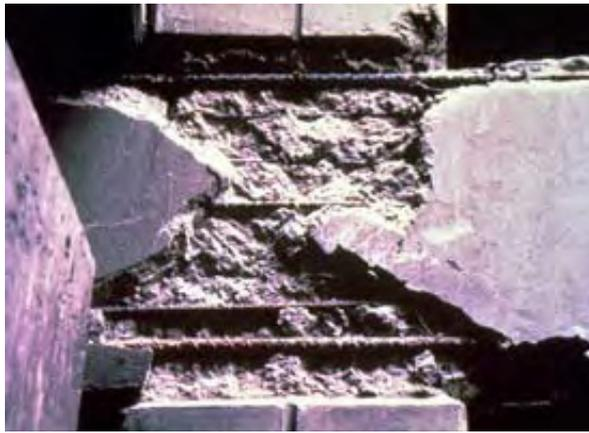
**Gambar 43.** Kegagalan geser pada pertemuan balok-kolom beton bertulang saat gempa Meksiko 1985, disebabkan oleh tulangan balok dipasang di luar penampang kolom (sumber: EERI 2000).
