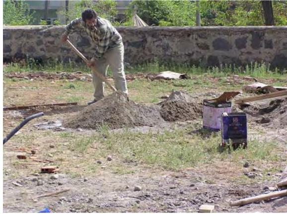
**Gambar 54.** Pencampuran dan penyiapan beton secara manual adalah pilihan terakhir karena ketidak mampuan menjaga konsistensi kualitas (foto: Irfanoglu).
