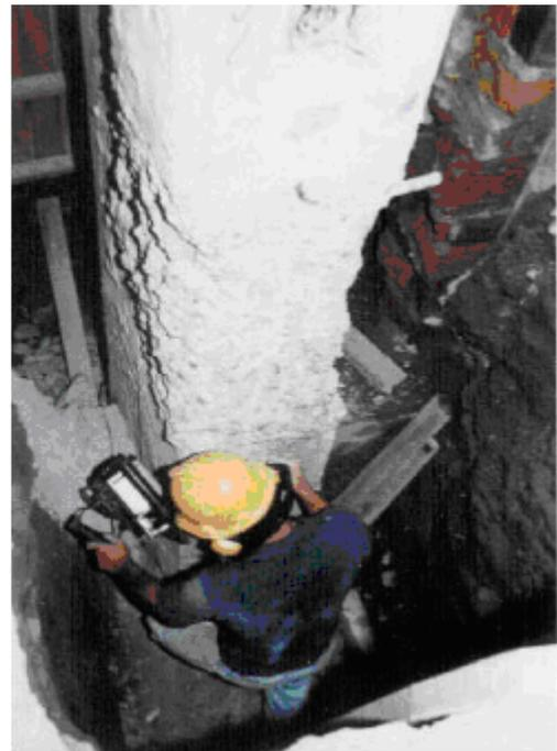
**Gambar 69.** Pemasangan lapisan beton bertulang dari level fondasi sampai ke bagian bawah balok; contoh dari Kolombia (sumber: Mejia 2002).
