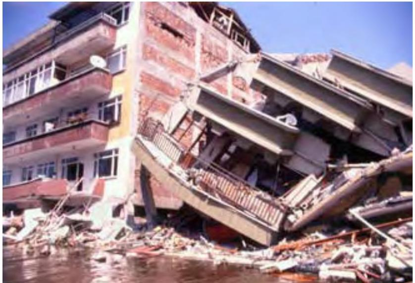
**Gambar 32.** Keruntuhan tingkat berganda pada sebuah bangunan 6-tingkat akibat desain dengan balok kuat – kolom lemah pada gempa Turki 1999 (sumber: Gulkan et al. 2002).
