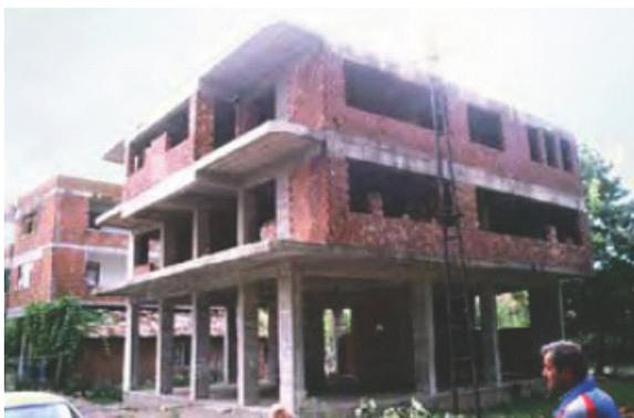
**Gambar 13.** *Tipikal konstruksi dinding pengisi dari bata merah di Turki: dinding pengisi dari bata ditambahkan setelah pelaksanaan konstruksi struktur rangka selesai (sumber: Gulkan et al. 2002).*
