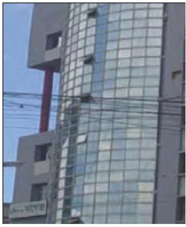
Elemen-elemen struktur (seperti kolom dan dinding) tidak seharusnya mengalami diskontinuitas (tak menerus) pada lantai-lantai bawah
