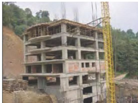
**Gambar 5.** Sebuah contoh pelaksanaan konstruksi struktur rangka beton bertulang di Mexico (sumber: Rodriguez dan Jarque 2005): pemasangan tulangan kolom (kiri) dan struktur rangka dengan dinding pengisi yang telah selesai dibangun (kanan).
