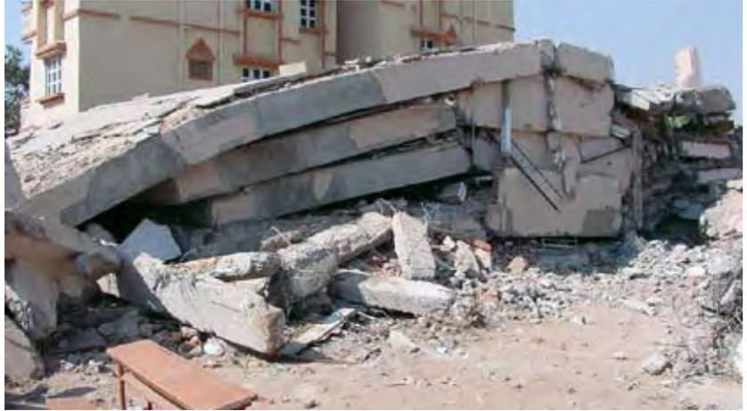
**Gambar 31.** Keruntuhan sebuah bangunan struktur rangka bertingkat akibat desain dengan prinsip “kolom lemah - balok kuat” pada gempa Bhuj 2001 di India (foto: C.V.R. Murthy).
