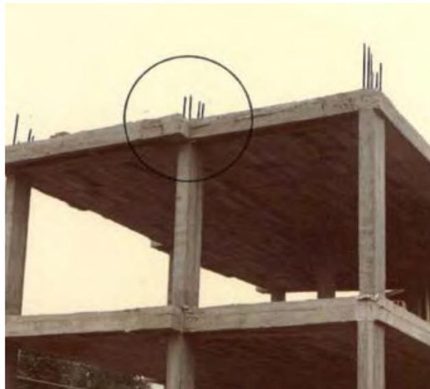
***Gambar 37.*** Panjang lewatan yang tidak cukup dan lokasi untuk pembangunan yang akan datang – 100% sambungan lewatan pada bagian bawah dasar kolom (sumber: Mejia 2002).
