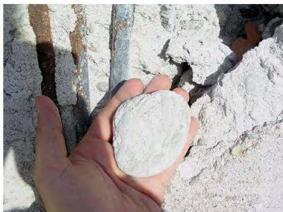
**Gambar 53.** Ukuran agregat yang tak memenuhi syarat; perhatikan beton berkualitas rendah dan porous dengan tulangan polos berkarat (foto: A. Irfanoglu).
