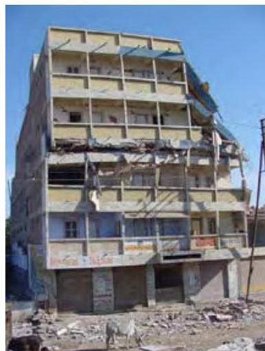
**Gambar 26.** Sebuah contoh bangunan yang roboh akibat tingkat “lunak” di tengah tinggi bangunan pada gempa Bhuj 2001 di India (sumber: EERI 2001).
