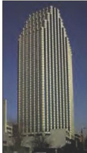
**Gambar 4.** Contoh-contoh bangunan beton bertulang bertingkat tinggi di Kanada (kiri; dari Pao dan Brzev 2002) dan Chile (kanan; dari Maroni dan Gomez 2002). Dinding geser beton bertulang memberikan ketahanan terhadap dampak gempa pada bangunan-bangunan ini, sedangkan kolom-kolom didesain untuk memikul beban gravitasi
