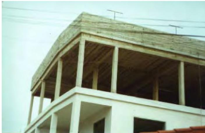
**Gambar 21.** Contoh sebuah bangunan rangka beton bertulang di Siprus yang menunjukkan kolom-kolom lemah, rangka tak lengkap dan dinding parapet yang berat dan kaku (sumber: Levitch 2002).
