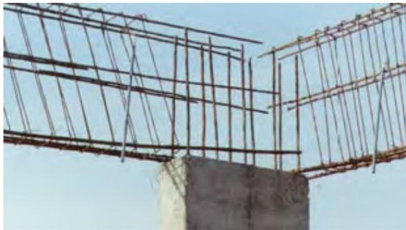
**Gambar 44.** Detail tulangan pertemuan balok-kolom yang kurang tepat: diskontinuitas tulangan balok pada pertemuan balok-kolom; tulangan-tulangan ini disyaratkan menerus dan memberikan kekangan pada beton di daerah pertemuan (tidak adanya sengkang pada pertemuan) (sumber: Jaiswal et al. 2002).
