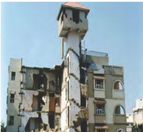
**Gambar 6.** Sebuah bangunan dengan bentuk yang tidak beraturan mengalami kerusakan yang ekstensif pada gempa Bhuj, India tahun 2001 (sumber: EERI 2001).
