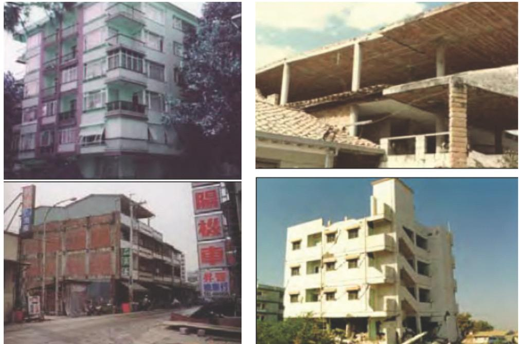
**Gambar 3.** Bangunan rendah hingga menengah berstruktur rangka beton bertulang: Turki (kiri atas; dari Gulkan et al. 2002); Kolombia (kanan atas; dari Mejia 2002); Taiwan (kiri bawah; dari Yao dan Sheu 2002); India (kanan bawah; dari Jaiswal et al. 2002)
