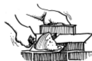
用小木板阻止接缝 里的砂浆溢出
