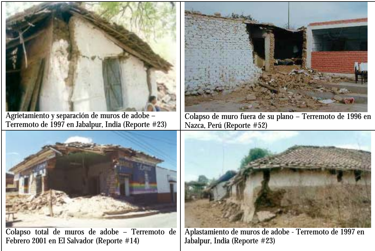
Figura 5 – Patrones Típicos de Daño por Terremoto (EERI/IAEE Enciclopedia Mundial de Vivienda) ( www.world-housing.net )
