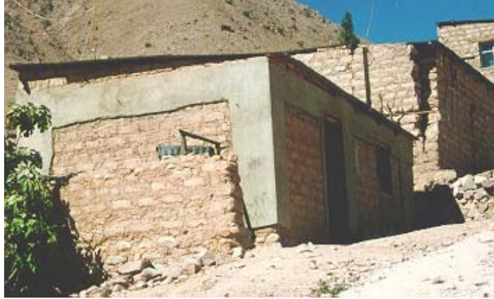
Figura 22 – Una Casa con Refuerzo Exterior de Malla Electrosoldada Sin Daño (primer plano). Detrás Aparece una Casa Sin Refuerzo Severamente Afectada por el Terremoto de Arequipa, Perú en 2001 (Zegarra y otros, 2001)
