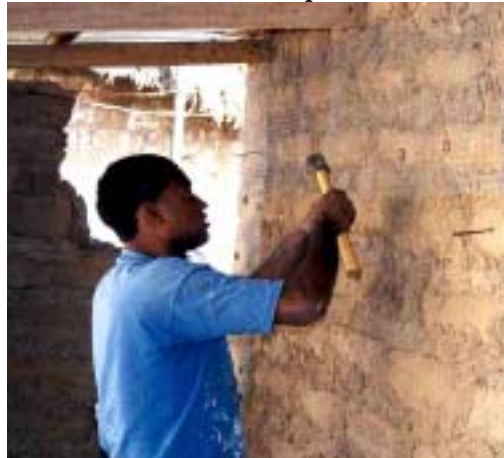
Figura 21 – Colocación de la Malla Electrosoldada en un Muro de Adobe Tradicional (Zegarra y otros, 1997).
