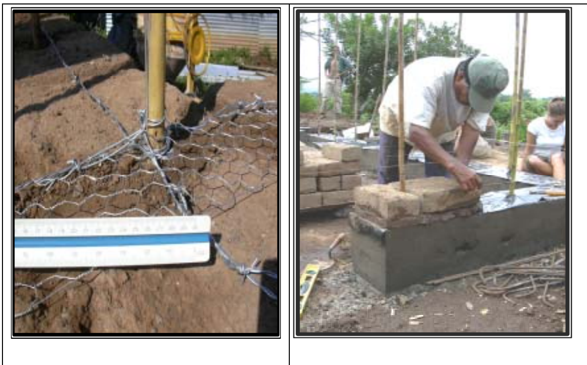
Figura 12 – Colocación del Refuerzo de Caña en El Salvador (Dowling 2002)
