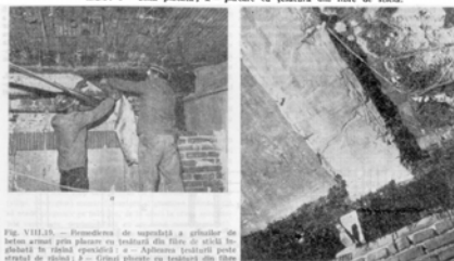
Fig. VIII.18. — Plasarea unei grăni de beton armat cu țesătură din fișe de sticlă, înglobată în cărți opoziție: 1 — zonă placată; 2 — placare cu țesătură din fișe de sticlă.
